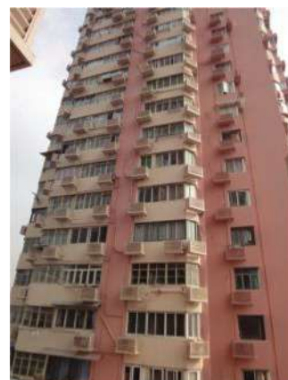
Appareils de climatisation type « split » sur la façade d'un bâtiment à Ouagadougou (Burkina Faso)
