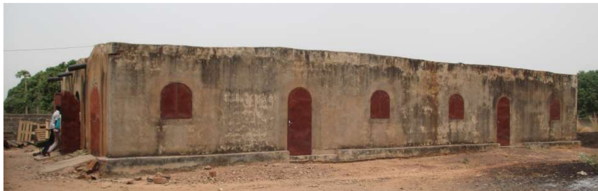
Façade nord du bâtiment de conservation de l'anacarde pour l'Association Wouol à Bérégadougou
