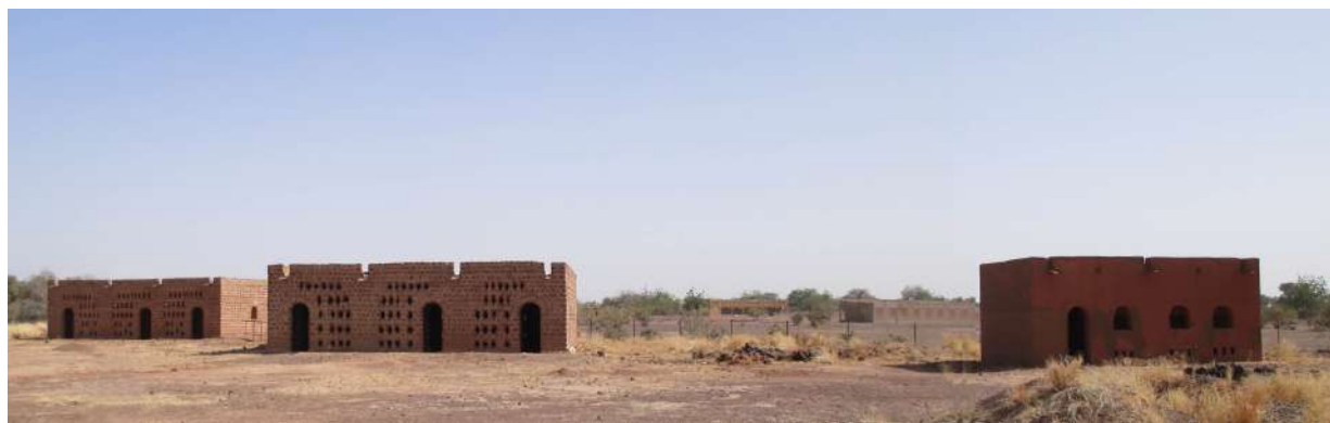
Bâtiments de conservation de l'oignon en voûtes nubiennes à Ouonon
