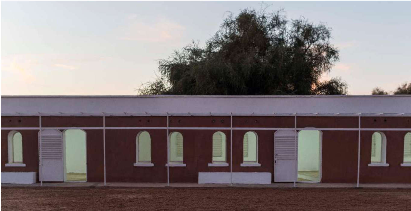
4. HYB : Salles de classe, École fondamentale de Dar Salam, Gorgol. (Photo Alfredo Caliz, 2020)
