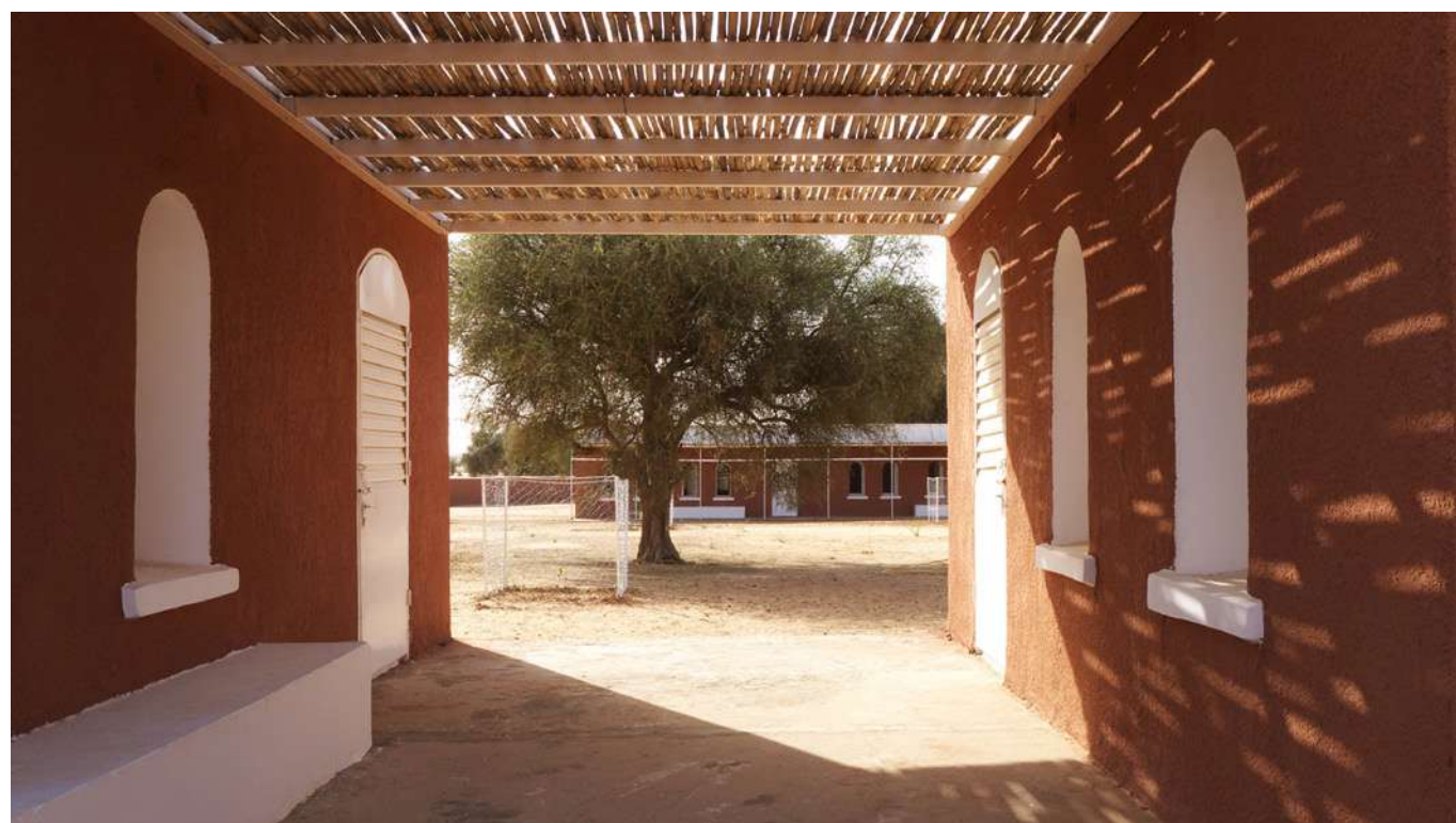
6. HYB : Administration, École fondamentale de Dar Salam, Gorgol. (Photo Mathieu Hardy, 2018)
