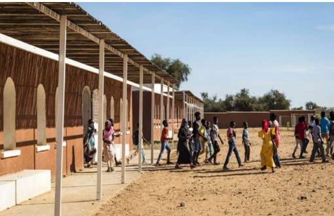
3. HYB : Salles de classe, École fondamentale de Dar Salam, Gorgol. (Photo Alfredo Caliz, 2020)
