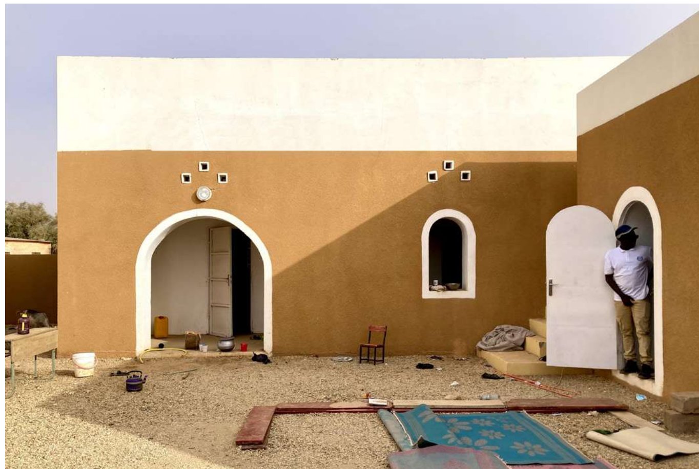
2. VN : Logement de Maîtres, École fondamentale 1 de Bassikounou, Hodh El Chargui. (Photo Mathieu Hardy, 2022)
