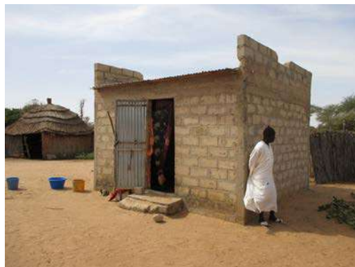
Disposition des ouvertures permettant une ventilation naturelle traversante du bâtiment afin d'atténuer l'inconfort
