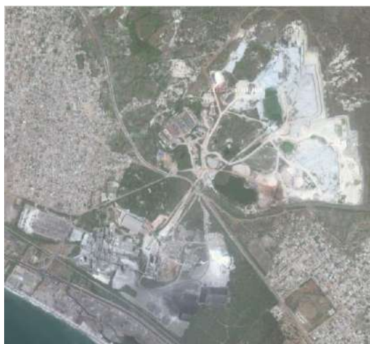
Vue aérienne de l'unité de production SOCOCIM à Rufisque
