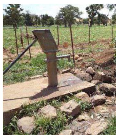
utilisation d'eau pour la mise en oeuvre
