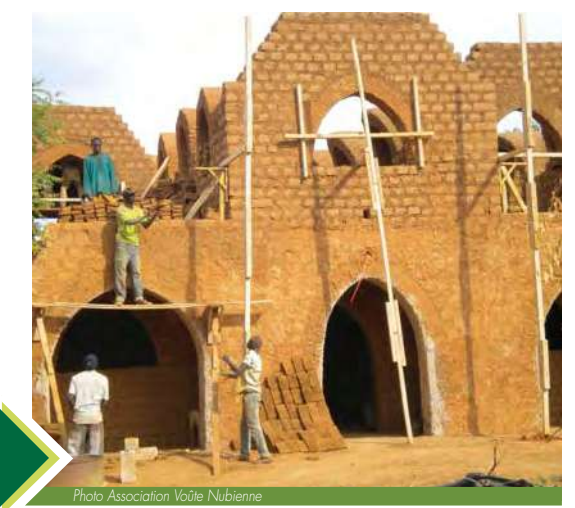
Photo Association Voûte Nubienne
