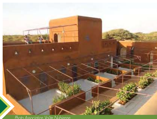
Photo Association Voûte Nubienne
