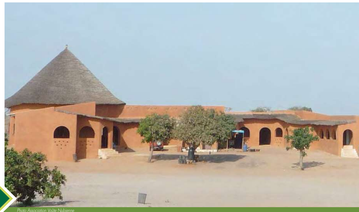
Photo Association Voûte Nubienne
