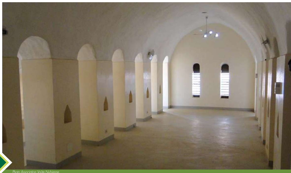
Photo Association Voûte Nubienne
