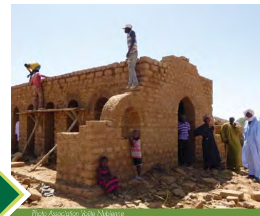
Photo Association Voûte Nubienne
