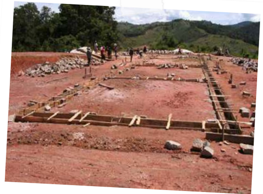
Réalisation des fondations du bâtiment, Madagascar.
