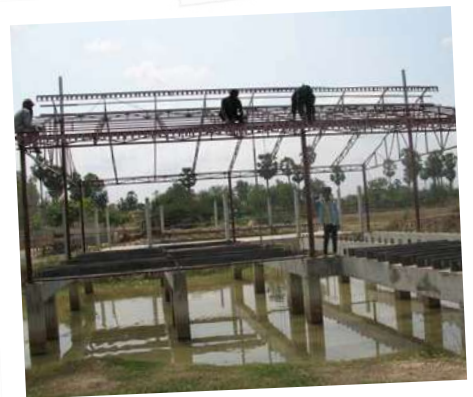
Construction de salles de classe sur pilotis, Cambodge.
