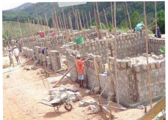
Maçonnerie des murs, Madagascar.
