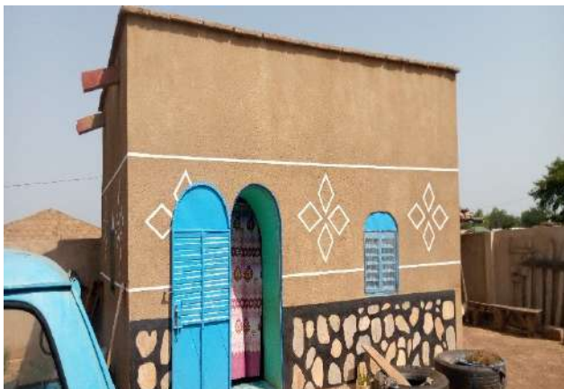
Façade de la maison d'habitation d'un personnel d'AVN.
