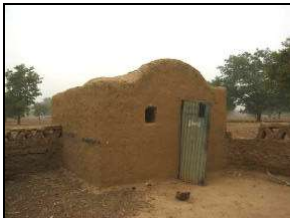
Figure 11 : A gauche : Lapara, VN très simple, Monopiece à 8 m 2 de surface habitable réalisé par étapes en 28 jours de travail ; A droit : Samandéni, VN plus sophistiqué, pied-droits en BLT, ouvertures en persiennes arrondis, voûtes décalés ; Wyss 2005
