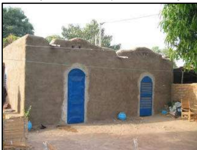
Figure 16 : Boromo, Structure d'accueil, AVN; Photo D. Sillou 2005
