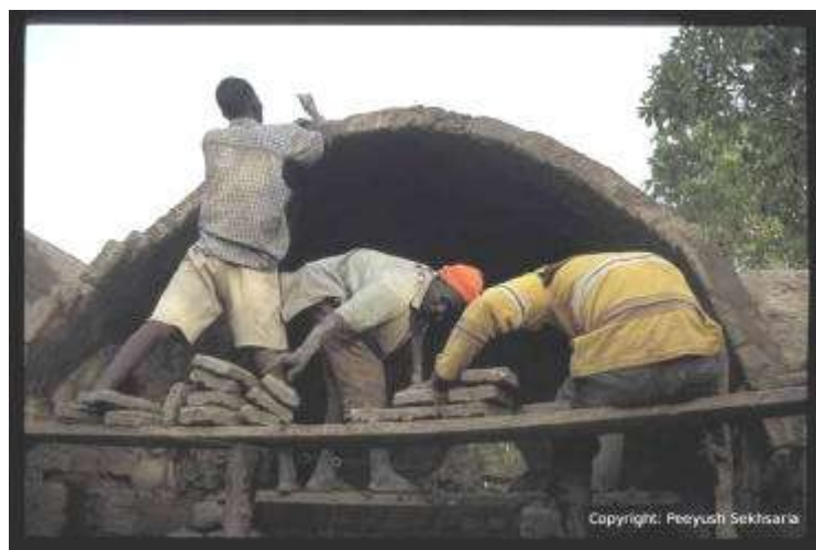
Figure 10 : Boromo, réalisation voûte ; Photo : P. Sekhsaria, 2005
