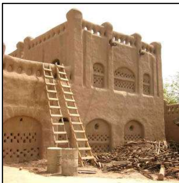
Figure 24 : Kokologho, Remplacement toiture Palais Naaba ; Wyss '05
