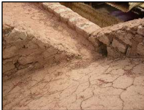
Figure 18 : Samandéni, 2 VN à orientation opposée accolées Evacuation des eaux non optimale : Photo : Wvss 2005
