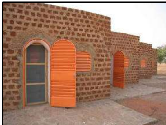
Figure 11 : A gauche : Lapara, VN très simple, Monopiece à 8 m 2 de surface habitable réalisé par étapes en 28 jours de travail ; A droit : Samandéni, VN plus sophistiqué, pied-droits en BLT, ouvertures en persiennes arrondis, voûtes décalés ; Wyss 2005
