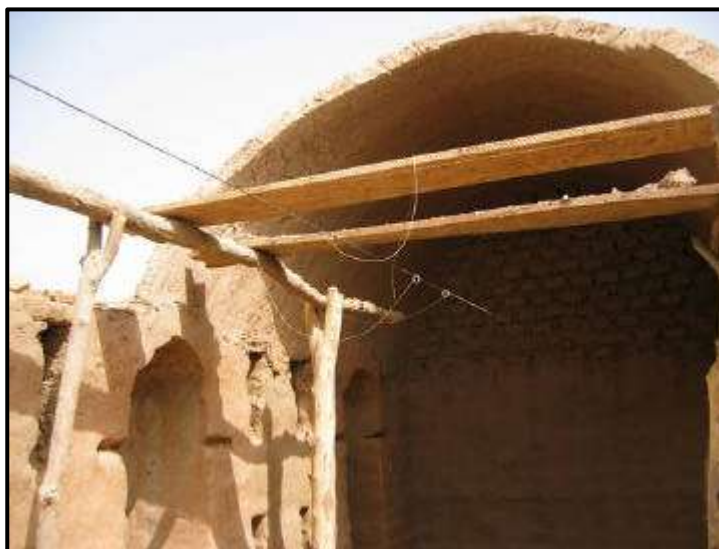
Figure 9 : Guide mobile : câble, anneaux et ficelles, Petit Balé ; Wyss 2005
