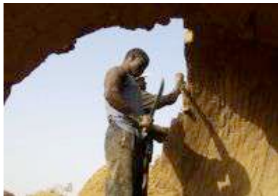
Chantiers VN au BF, 2009
