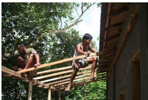
Dak van veranda
